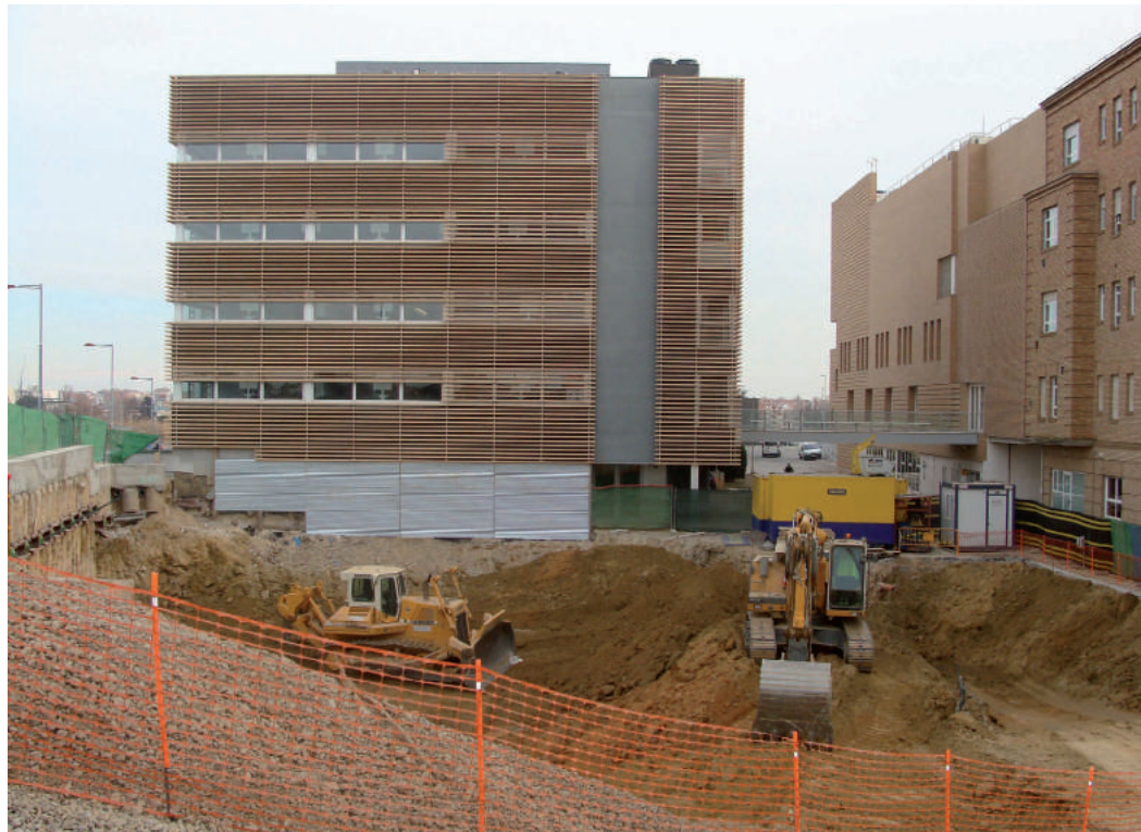
Foto 1: L'any 2011 es van iniciar les obres del segon edifici de Biomedicina.
